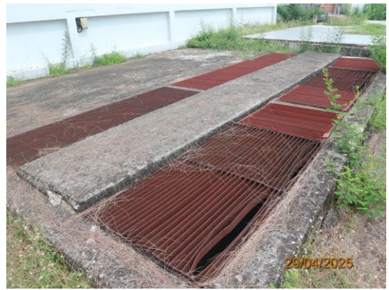
รูปที่ 3.1-11 บ่อพักน้ำหลังการบำบัด
